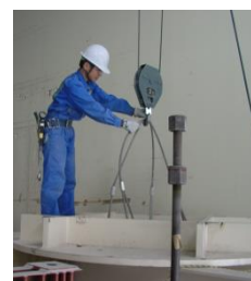
写真6 玉掛・クレーン作業
