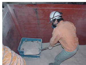
写真6 粉塵・発汗作業 (ダクトによる換気)
