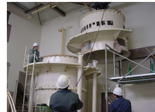
写真3 クレーン作業 (装置の組み立て作業)
