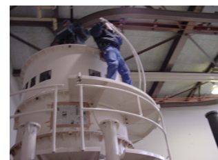
写真5 高所作業 (安全柵の取付け)
