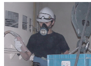
写真7 粉塵中での作業 (保護具類の着用)
