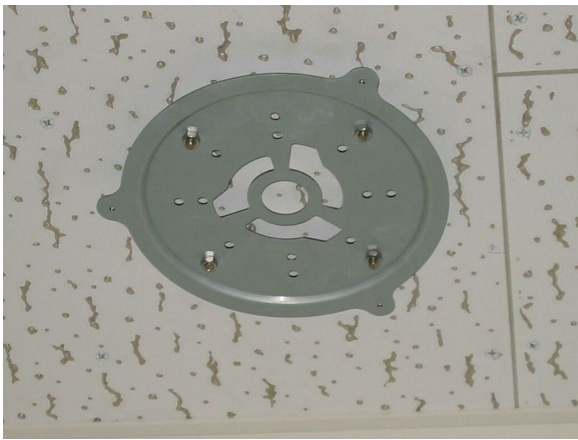
図 6 取り付け用金具の固定
