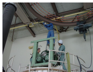
写真4 高所作業 (天井付近への吊具取付作業)
