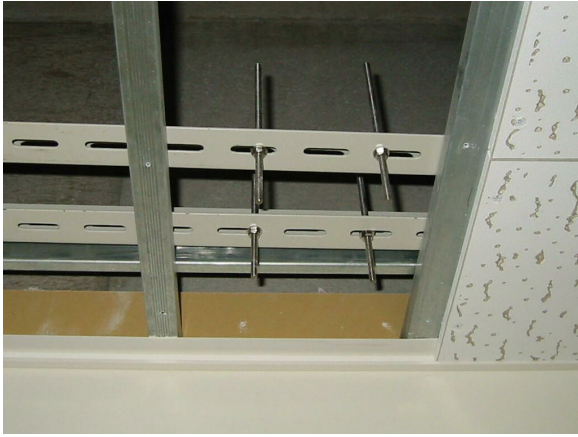
図 4 取り付け用金具の設置
