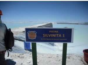
写真1. リチウム回収沈殿池
