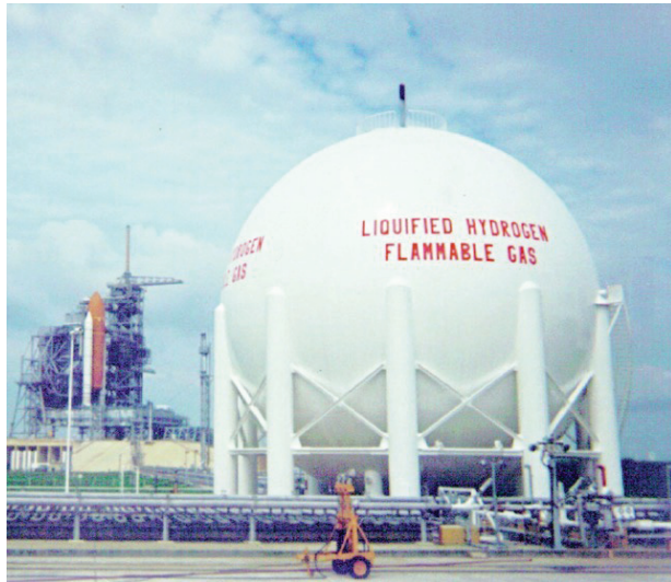
米国ケネディー宇宙センターの 液体水素貯槽（後方はスペースシャトル）
