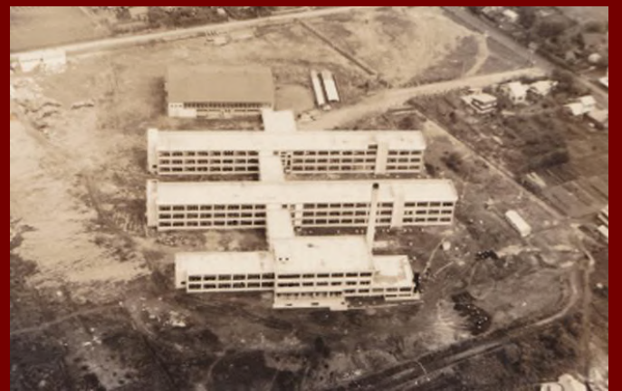
写真7 札幌西高・旧校舎の航空写真
