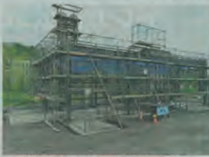
三笠市界別町で建設が進む地上プラント。後ろには旧界別炭鉱立て坑やぐらがある
