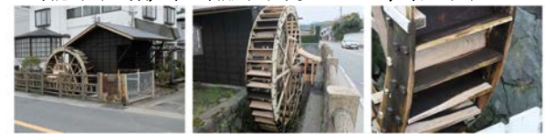
左: 車軸受け, 中: 水車骨組み, 右: 水車設置水路
