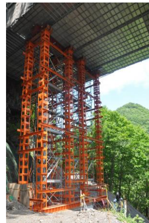
写真4 ジャッキアップ用架設ベントの設置状況
