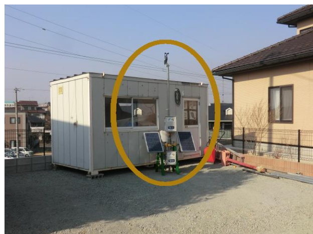
図2 実証実験システム設置の全景
