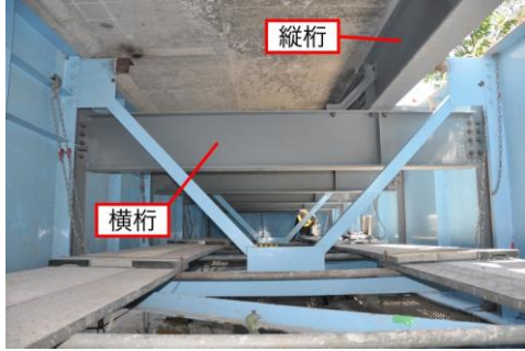
写真5 床組増設状況
