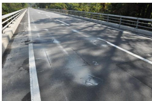
写真 3 床版の部分補修状況
