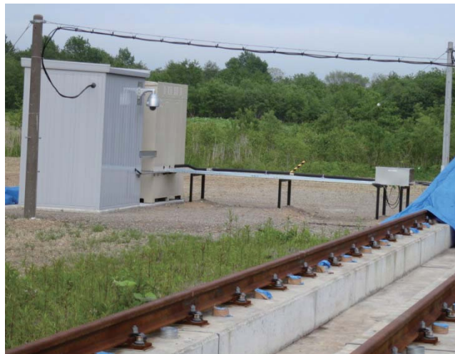
図3 計測器・ポンベ保管庫
