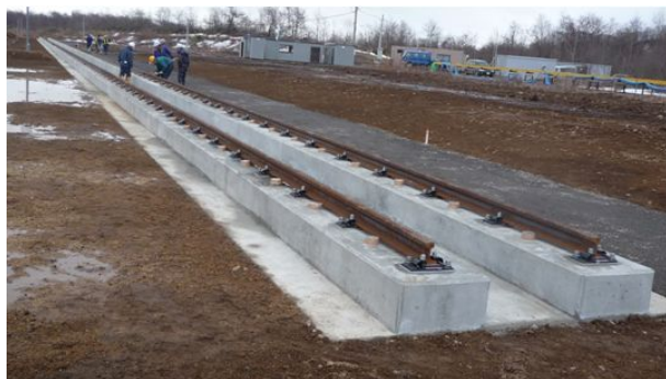
平成21年3月工事の完成検査
