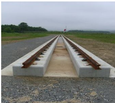
平成20年度に設置した150mの軌道
