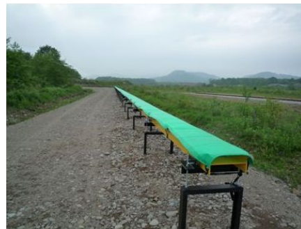
軌道に施した防護カバー
