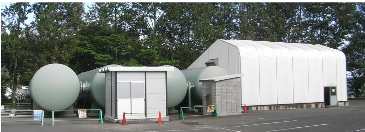
図 8：4 基に増設した真空タンクと増設した真空排気装置の建屋
