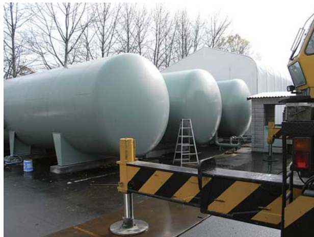
図2：3基目の真空タンクの設置工事
