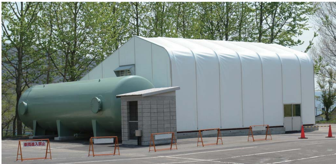
上屋を設置した後の風洞設備の外観
